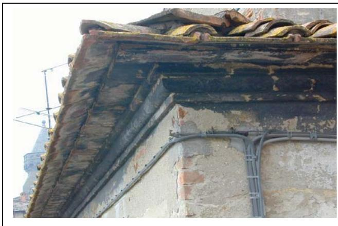
Si individuano chiaramente le varie file di elementi aggettanti con differente spessore e sagoma, malgrado la successiva tinteggiatura di colore grigio scuro identica a quella della fascia sottogronda di intonaco aggettante. In totale le file sono tre più il forte aggetto realizzato con piastre di laterizio, probabilmente gronde rovesciate su cui sono murati gli embrici inclinati della copertura
