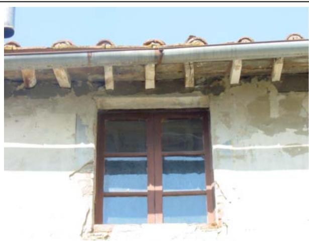
Questa tipologia è spesso utilizzata in casi di edilizia di base di matrice rurale molto semplice, proprio per la facilità di montaggio; anche in questo caso il legname veniva trattato con tinteggiature per proteggerlo da l'aggressione di tarli e muffe.
