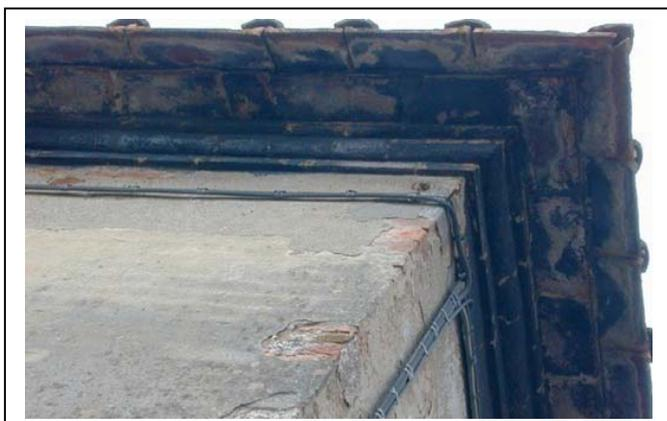
In angolo quando il tetto è rigirante si necessita di un elemento di grosse dimensioni in quanto deve aggettare su entrambe i lati. In questo caso la tipologia è ancora quella originaria in cui non è mai stato inserito il canale di gronda.
