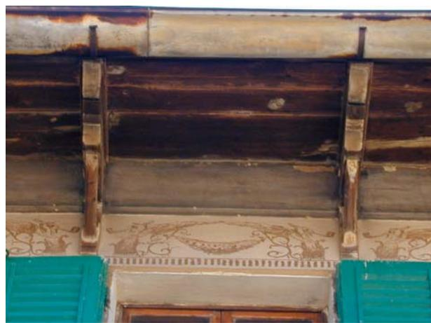
Realizzazione di gronda completamente lignea, con mensole lavorate in legno e scempiato in tavolato di legno. La colorazione scura dipende sia dalla tinteggiatura che dall'ossidazione del tempo.
