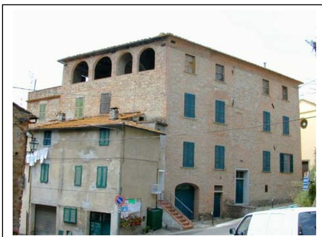
Edificio con facciate completamente stonacate con regolarità delle aperture e particolare rilevanza del rapporto tra pieni e vuoti. Dalla tessitura muraria in pietra e laterizio emergono alcuni archi di scarico al di sopra delle aperture realizzati comunque per essere intonacati.
