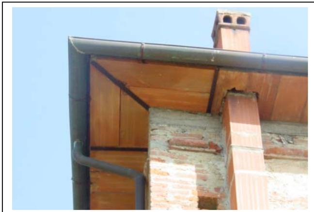
Realizzazione di aggetti notevoli su coperture rigiranti a padiglione; per risolvere il problema dell'angolo si utilizzano profili in ferro; in questo caso oltre al rifacimento della copertura si è avuto una sopraelevazione di cui ancora rimane segno nella vecchia cornice modanata.
