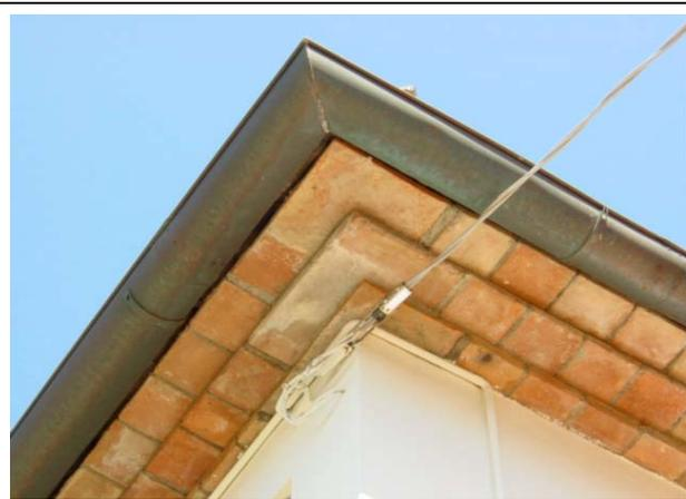
Particolare dell'angolo in cui sono messi in opera elementi di laterizio di dimensioni maggiori in quanto con mezzane e mattoni ciò non sarebbe possibile; spesso sono utilizzati a questo scopo gli embrici che vengono utilizzati per la prima fila della copertura, o in alternativa piastre di laterizio realizzate appositamente.
