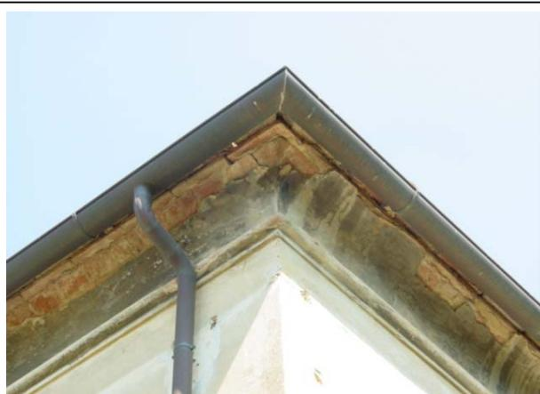
Si nota al di sotto dell'intonaco il sistema costruttivo costituito da elementi di laterizio gradualmente aggettanti e di dimensioni variabili.
