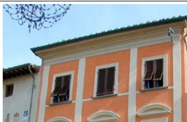
Il cornicione fa parte di un apparato decorativo completo di facciata e risulta come elemento conclusivo di trabeazione su lesene di ordine gigante. Si tratta di interventi di abbellimento della città ed arricchimento delle facciate che nell'ottocento trasformano le tipologie edilizie ed i contesti urbani.
