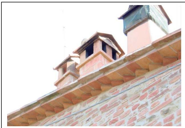
Particolare del prospetto laterale in cui si ripropone lo stesso motivo decorativo; il riproporre lo stesso motivo è forse frutto di un eccessivo arricchimento formale a seguito degli interventi di ristrutturazione. È troppo consistente l'aggetto della seconda fila di mezzane rispetto a quello della fila dentellata;
