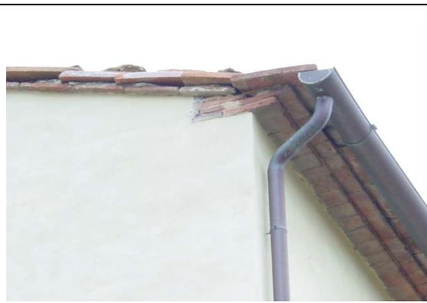
Particolare di una copertura a capanna a due falde con gronda in elementi di laterizio in doppia fila aggettanti; è importante la gerarchia tra il prospetto principale e quello laterale in cui solo una fila di mezzane poste per il lato lungo, aggetta di pochi centimetri;
