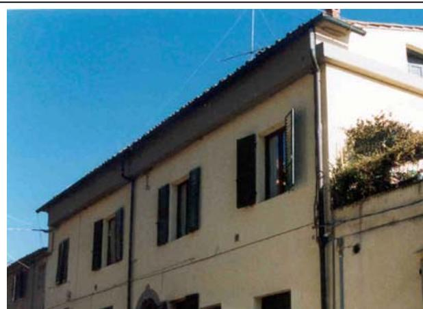
Particolare di un cordolo in c.a. con funzione statica realizzato a seguito di ampliamenti in altezza con sopraelevazione della gronda originaria. Il risultato è incongruo rispetto alla tipologia dell'edificio.
